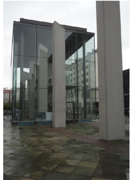
Fertigstellung der Glasfassade
