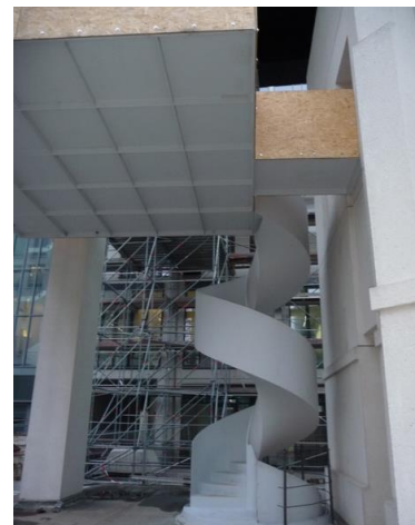
Wendeltreppe zur Erschließung des freitragenden Podestes
