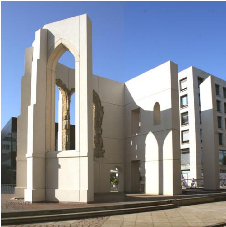
Fertigstellung der Rohbauarbeiten der Kapelle
