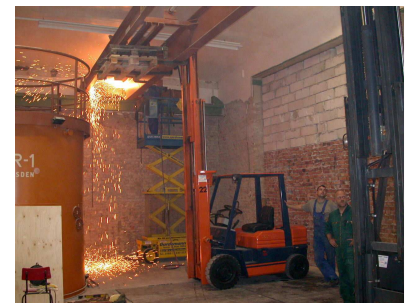
Rückbau des alten Brückenkranes
