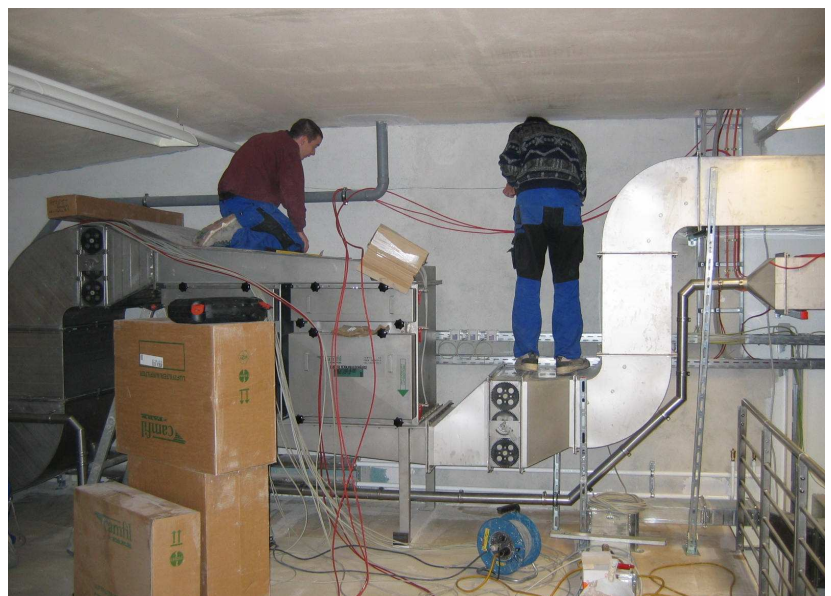
Montage der raumlufttechnischen Anlagen
