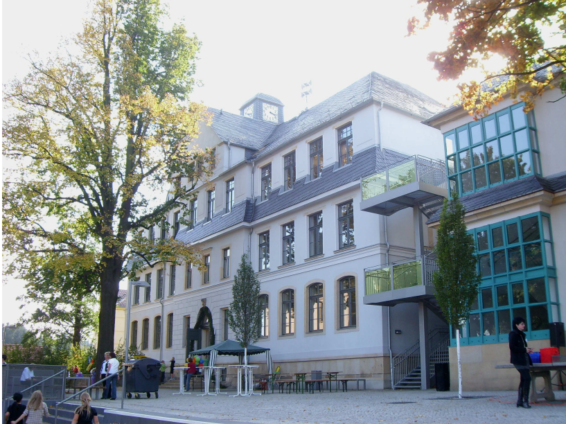
Blick auf die Straßenfassade nach der Instandsetzung
