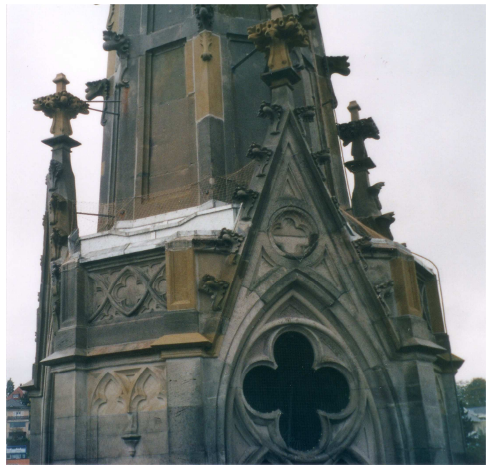
Turmhelm mit ausgetauschten Werkstücken und neuer Blechabdeckung
