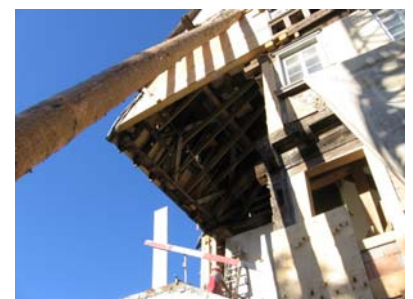
Bauzustand „Rückbau des nicht bauzeitlichen Treppenhauses in der SO-Ecke“
