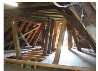
Blick in einen Teil des Dachgeschosses
