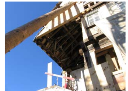
Bauzustand „Rückbau des nicht bauzeitlichen Treppenhauses in der SO-Ecke“
