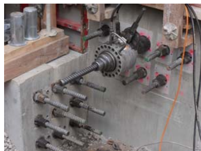
Detail Spannbeton mit Hydraulik
