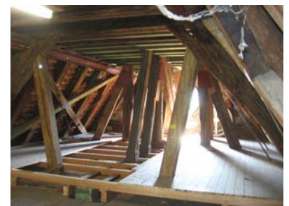
Blick in einen Teil des Dachgeschosses
