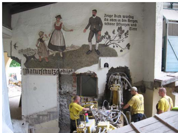
Kernbohrgerät für Pfahlgründung an Innenwänden
