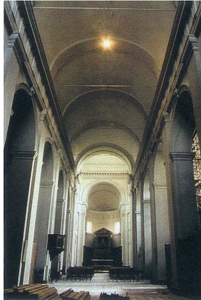
Innenansicht nach Osten
