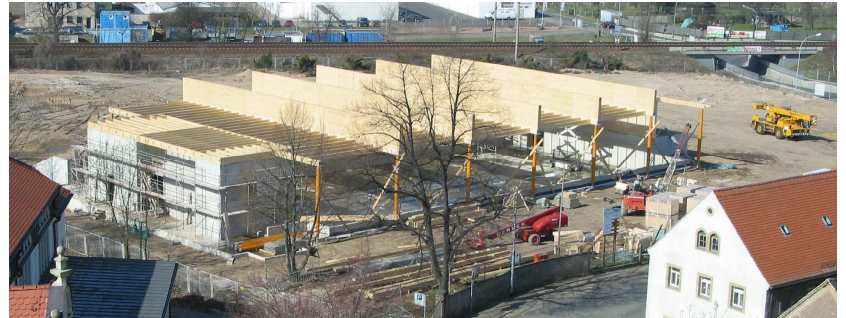
Gesamtansicht im Bauzustand
