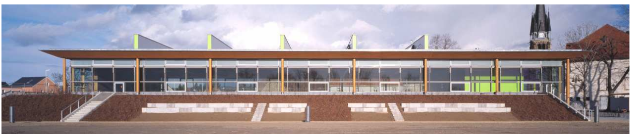
Ansicht der fertigen Halle
