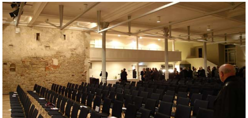
Sichtbarer Untergurt der Tragkonstruktion über dem Sonnensaal
