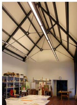
Polonceuträger Bereich Kunstschule
