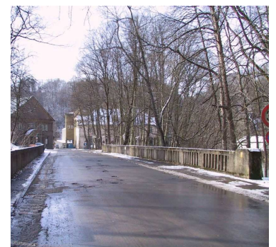
Fahrbahn und Betongeländer
