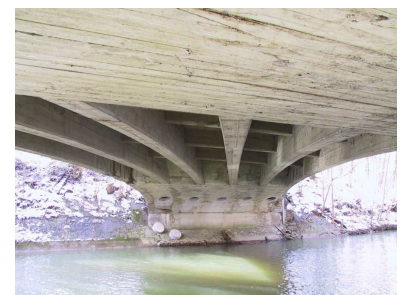
Untersicht unter den Plattenbalken
