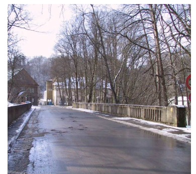
Fahrbahn und Betongeländer
