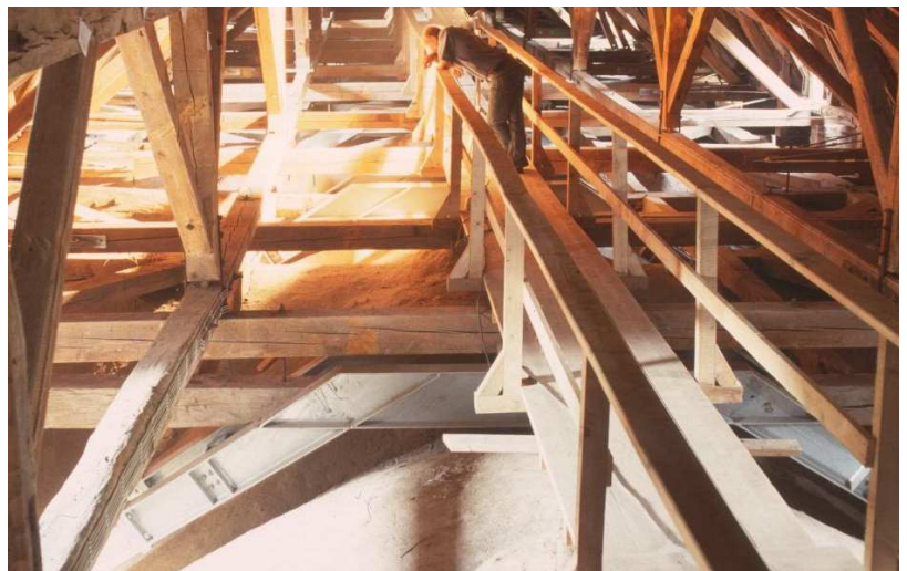
Stählerner Klammer im Dachraum
