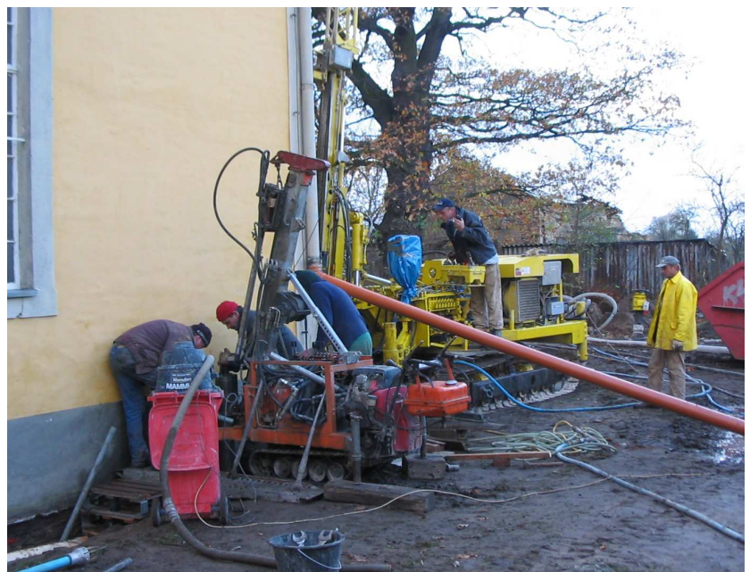
Kernbohrgerät (im Vordergrund) und Düsenstrahlgerät (im Hintergrund)
