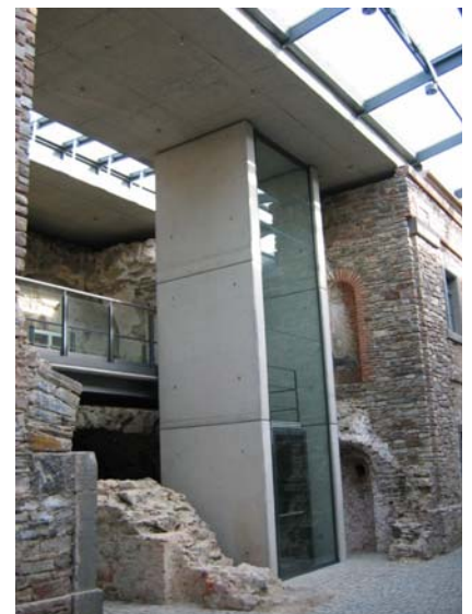
Großer Bombentreffer im Innenhof Lange Linie
