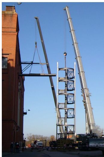
Aufrichtung des Zugangstreppeenturmes am 28. November 2008
