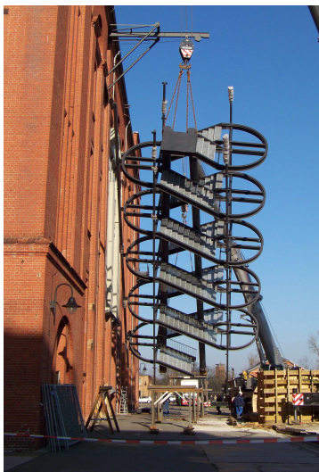
Aufrichtung des Zugangstreppeenturmes am 28. November 2008
