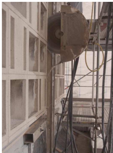
Sägeschnitt in einer Vertikalfuge
