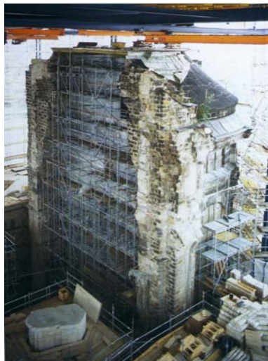
Eingerüstete Apsis (Bestand)
