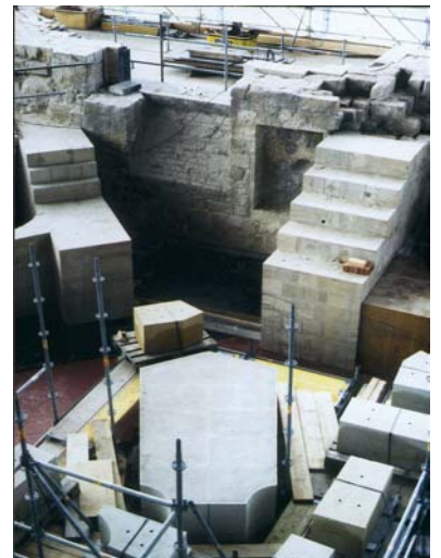
Neue Innenpfeiler im Bestand
