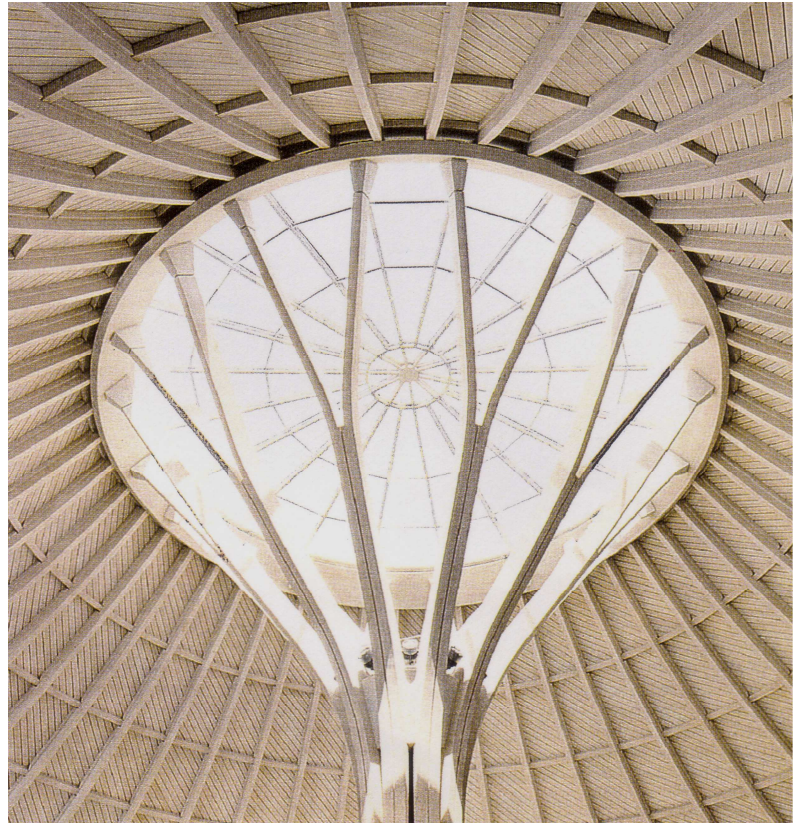
Untersicht der Baumstütze
