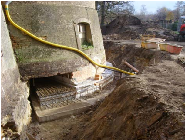
Einbau Bodenplatte
