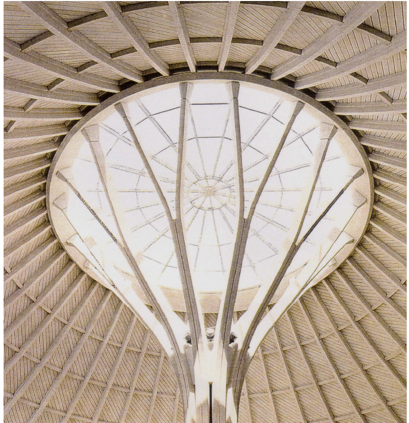
Untersicht der Baumstütze
